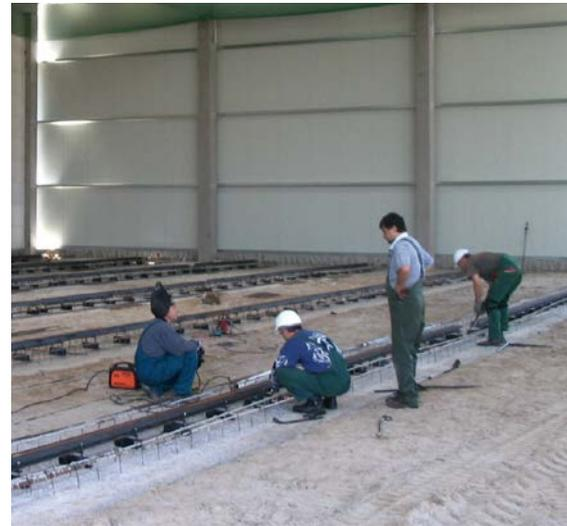
In bestehenden Hallen wird nach Bodenprüfung eine entsprechende Verlegeart gewählt. Dafür wird die Fläche für den Schienenbereich z.B. ausgefräst oder auf den vorhandenen Boden aufgebracht.
